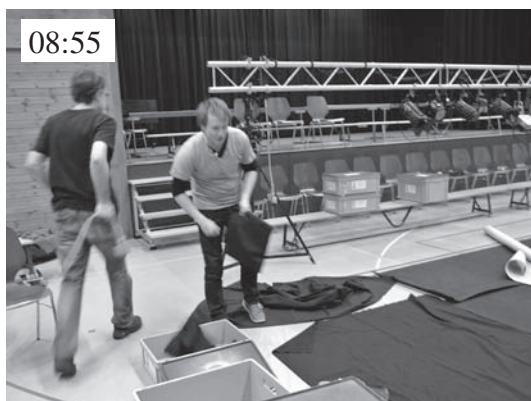
Scheinwerfer werden montiert.
